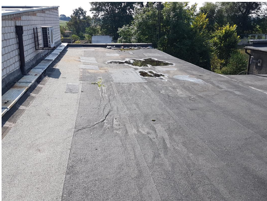
Fot. 17 – Deformacje połaci dachowej.
