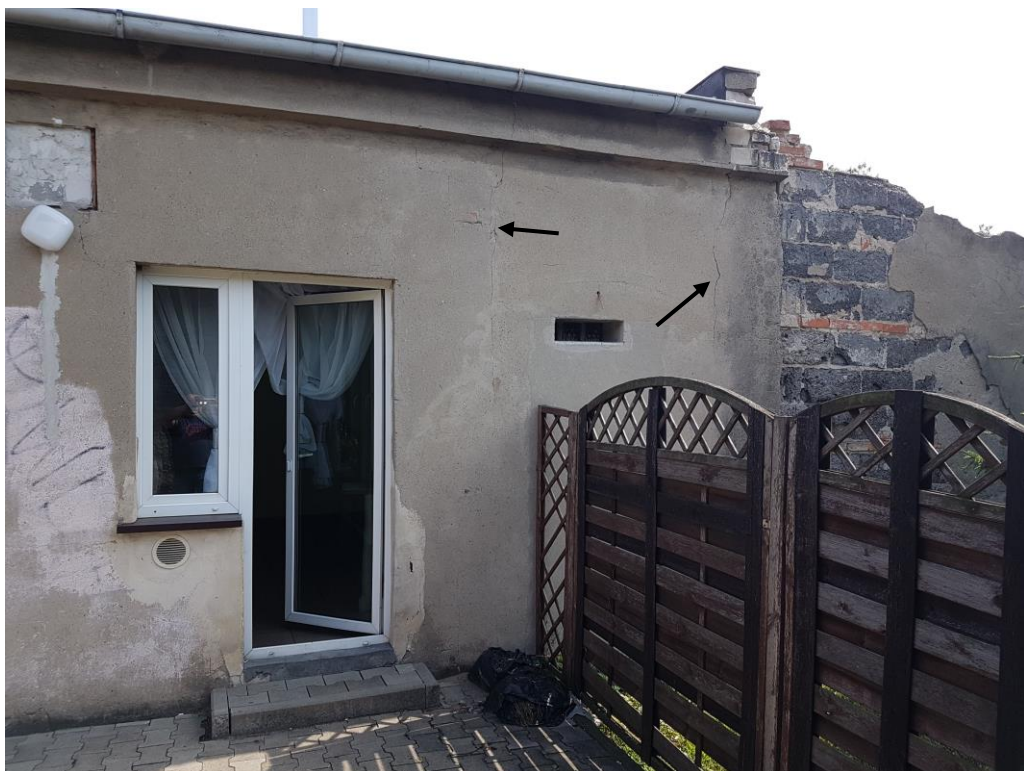
Fot. 6 – Przykład zarysowań na tynku elewacyjnym.
