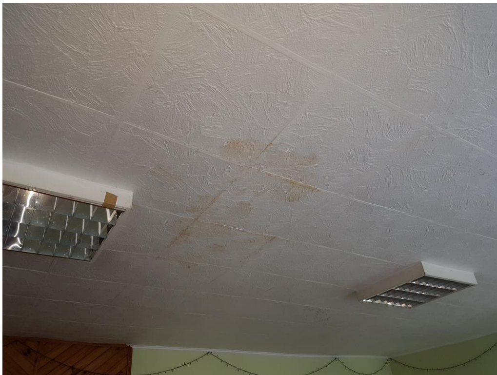
Fot. 19 – Ślady zawilgoceń na suficie świetlicy.
