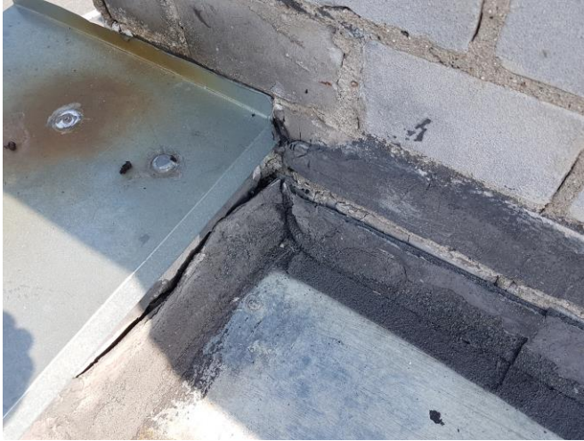
Fot. 11,12 – Nieszczelności obróbek blacharskich – styk murku ogniowego ściany bocznej z attyką ściany frontowej – korozja blachy, nieszczelności, odspojenia obróbek oraz papy powodujące możliwość infiltracji wody opadowej pod pokrycie papowe.
