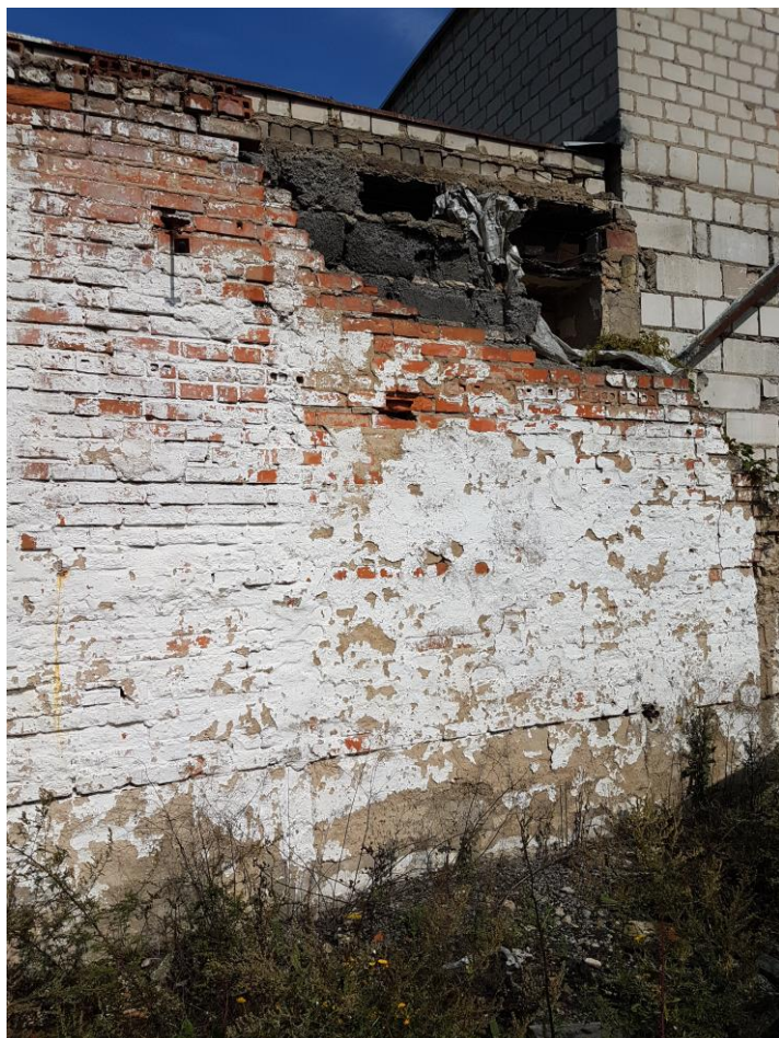
Fot. 7 – Szczyt południowo-wschodni – wyrwa w murze po rozbiórce obiektu na działce sąsiedniej (wspólna ściana).
