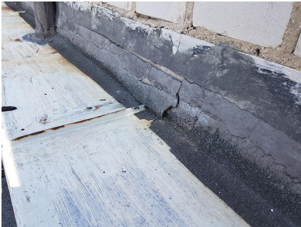
Fot. 15 – Kolejny przykład nieszczelności w obrębie murka ogniowego.
