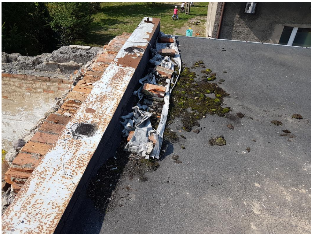
Fot. 16 – Korozja murka ogniowego tylnej ściany szczytowej, widoczne zalegające śmieci na dachu oraz porosty mchu na pokryciu papowym.
