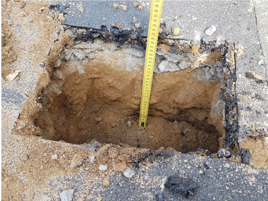
Fot. 21 – Pomiar grubości warstw w odkrywce konstrukcyjnej (odkrywka „B”)
