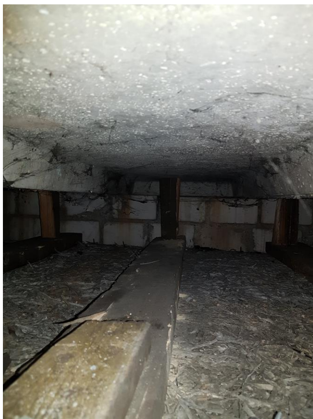
Fot. 23, 24 – Podkonstrukcja sufitu podwieszanego. Na fot. 24 (po prawej) widoczny zalegający gruz na supremie.
