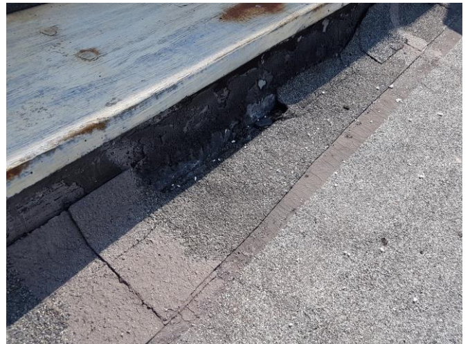
Fot. 13, 14 – Przykład niewłaściwie wykonanej obróbki papowej murka ogniowego. Widoczne odspojenia i uszkodzenia papy.
