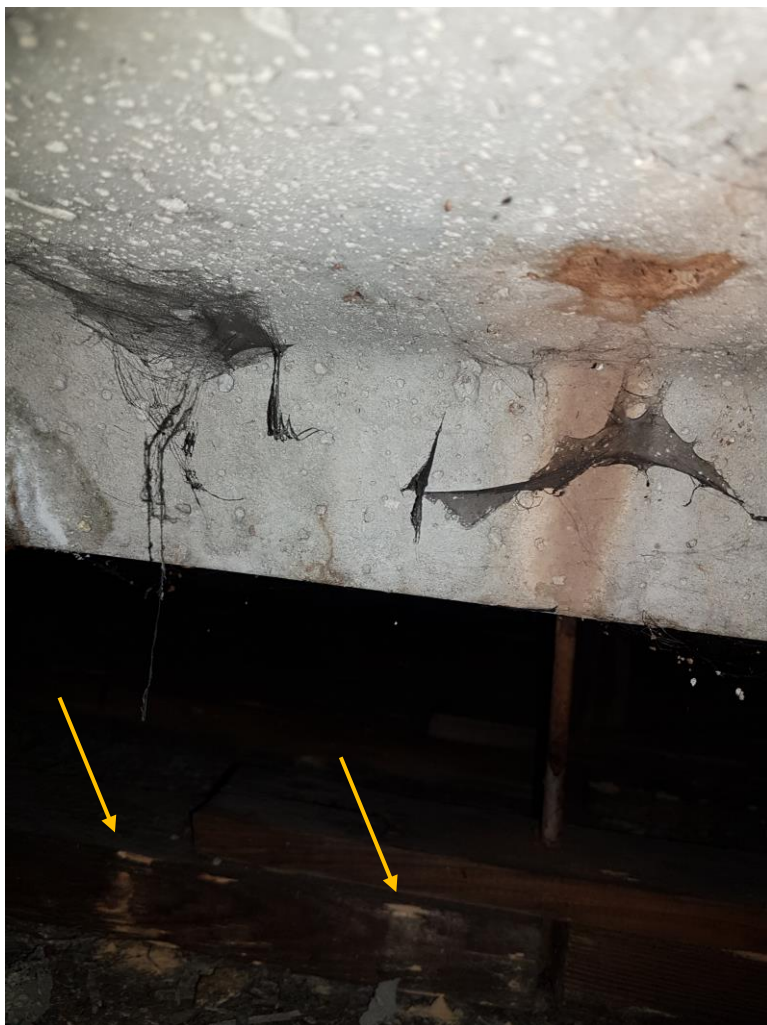
Fot. 25 – Zarejestrowane ślady bytności owadów, szkodników drewna oraz rdzawy ślad na płycie dachowej świadczący o nieszczelności pokrycia dachu.
