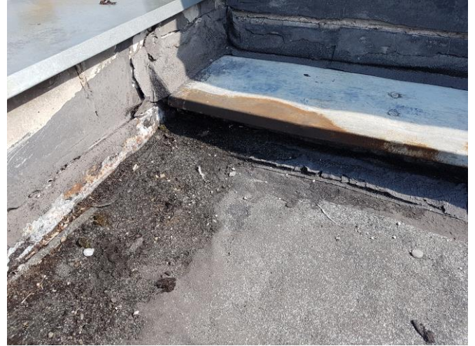
Fot. 11,12 – Nieszczelności obróbek blacharskich – styk murku ogniowego ściany bocznej z attyką ściany frontowej – korozja blachy, nieszczelności, odspojenia obróbek oraz papy powodujące możliwość infiltracji wody opadowej pod pokrycie papowe.
