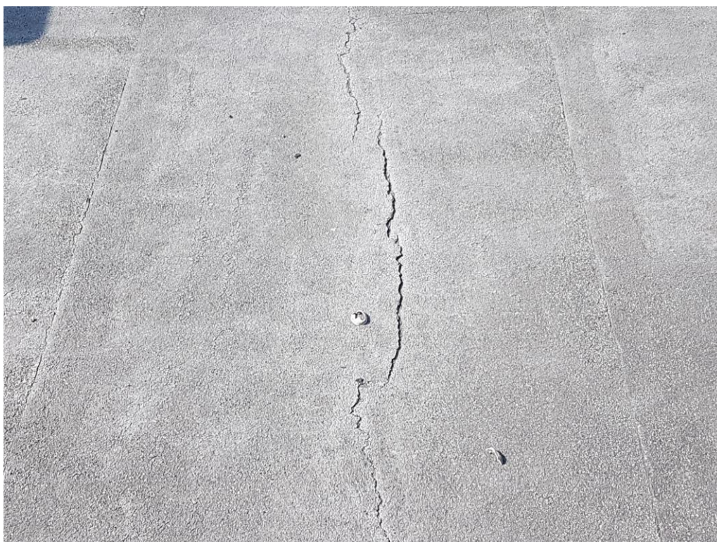
Fot. 18 – Uszkodzenia pokrycia papowego.
