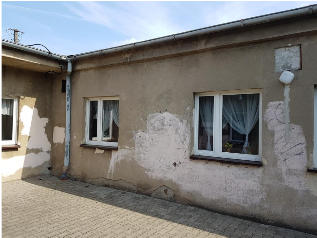
Fot. 5 – Uszkodzenia i ubytki tynku elewacyjnego.
