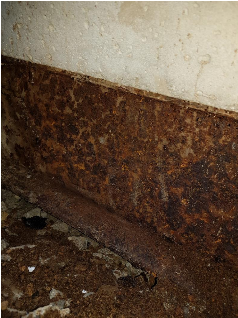
Fot. 22 – Belka stalowa INP 200 w odkrywce „E” – widoczna korozja powierzchniowa.
