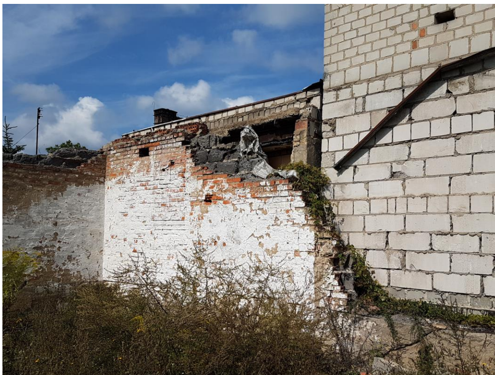
Fot. 4 – Ściana szczytowa świątlicy – strona południowo-wschodnia. Uwagę zwraca wyrwa w murze powstała podczas rozbiórki obiektu na działce sąsiedniej.
