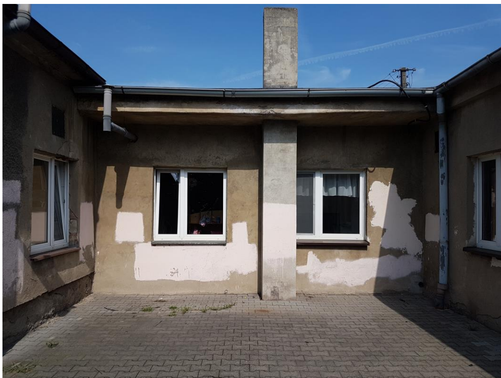
Fot. 2 – Elewacja wewnętrzna (strona południowo-wschodnia). Część komunikacyjna współdzielona z przedszkolem.
