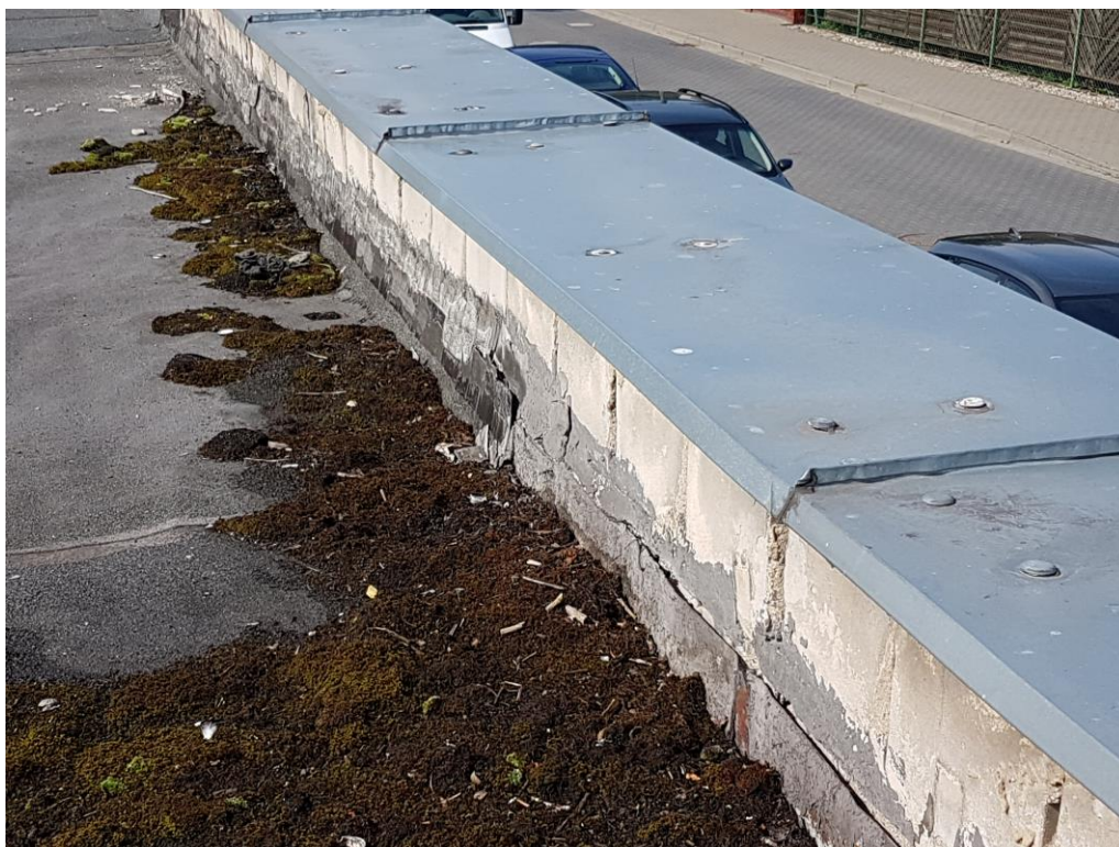
Fot. 10 – Attyka ściany frontowej – widoczne nieszczelności obróbek blacharskich i mech na pokryciu papowym.
