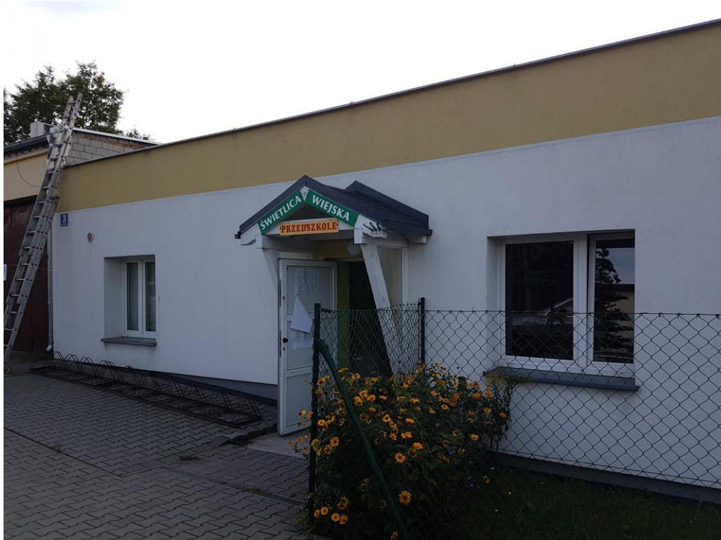
Fot. 1 – Widok ogólny elewacji frontowej (strona północno-zachodnia).
