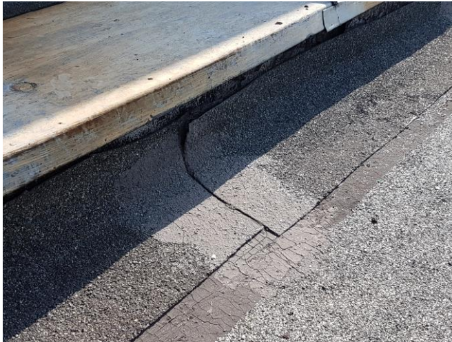
Fot. 13, 14 – Przykład niewłaściwie wykonanej obróbki papowej murka ogniowego. Widoczne odspojenia i uszkodzenia papy.
