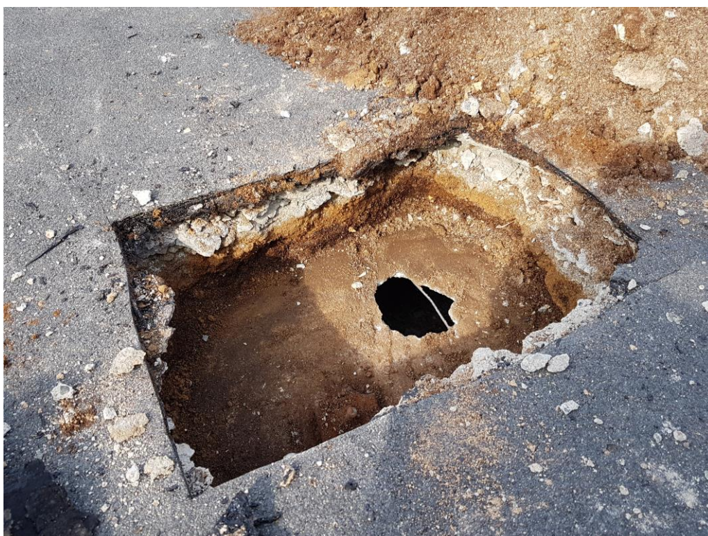
Fot. 20 – Odkrywka konstrukcyjna ustalająca układ warstw dachowych (odkrywka „A”).
