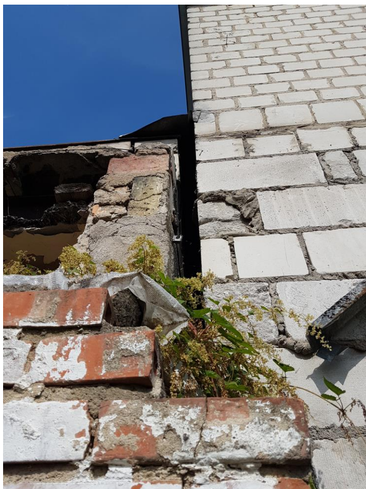
Fot. 8 – Niezabezpieczona przed wnikaniem opadów atmosferycznych szczelina pomiędzy budynkami.
