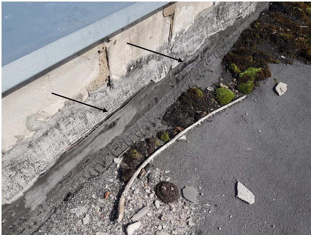
Fot. 9 – Nieszczelności obróbki blacharskiej atyki ściany frontowej.
