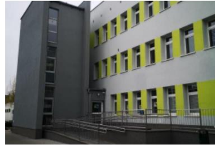
Adaptacja budynku ośrodka zdrowia na Urząd w Mosinie, ul. Dworcowa 3
