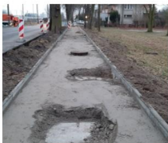
Budowa chodnika na ul. Kolejowej
