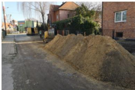
Budowa ulicy Kanałowej i Łaziennej
