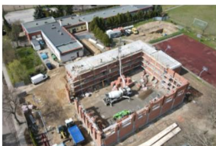
Budowa sali gimnastycznej przy SP w Rogalinie
