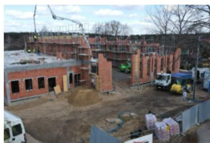
Budowa sali gimnastycznej przy SP w Rogalinie
