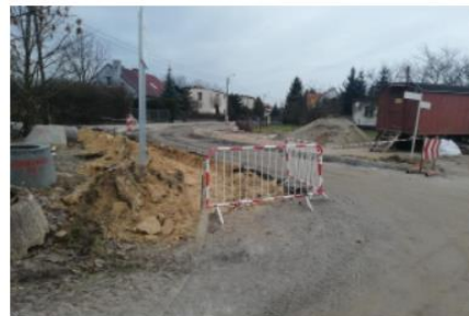
Budowa ul. Piaskowej w Mosinie
