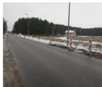
Budowa ścieżki pieszo-rowerowej w ul. Poznańskiej w Daszewicach
