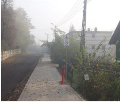
Chodnik na odcinku Mosina - Żabinko
